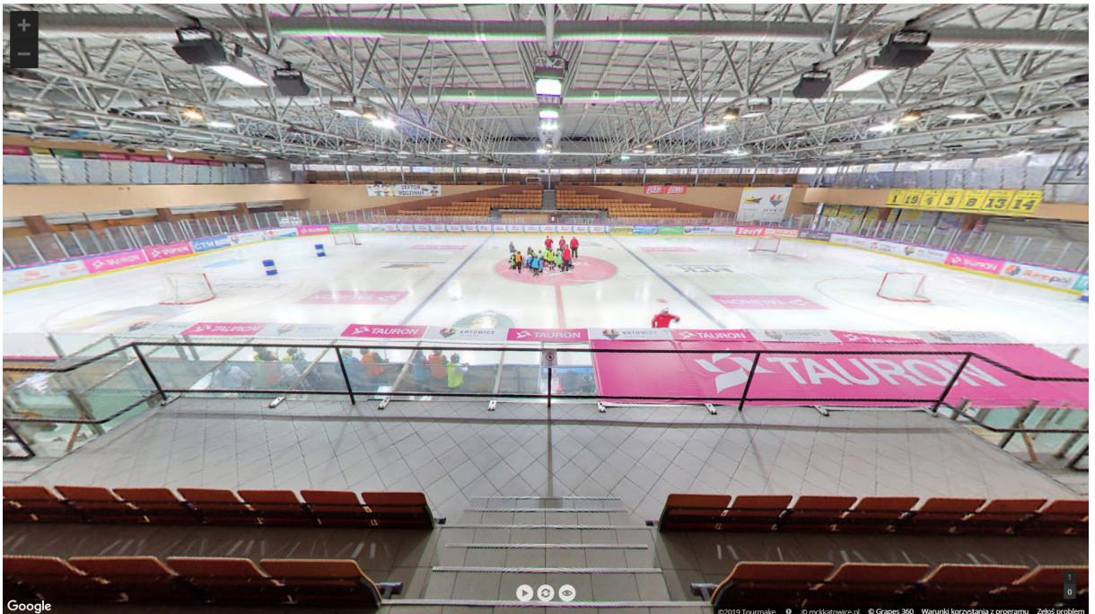
Ryc. 5 Hala lodowa ośrodka sportowego „Spodek”
