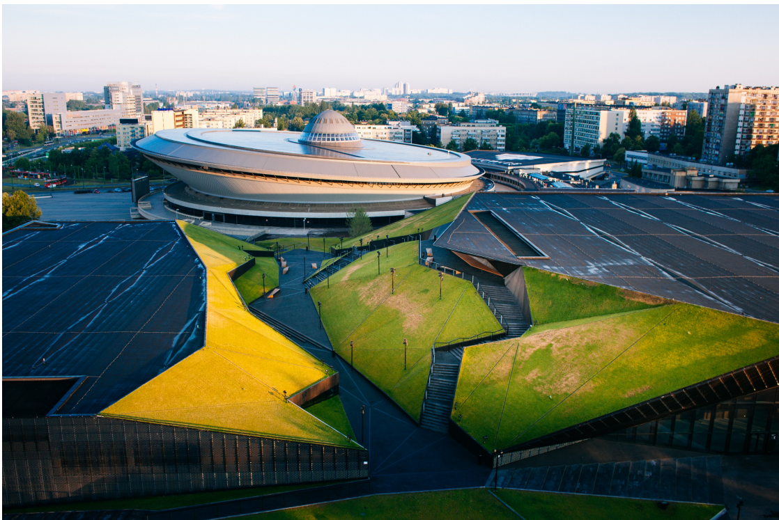
Ryc. 8 „Spodek” od strony Międzynarodowego Centrum Kongresowego w Katowicach
